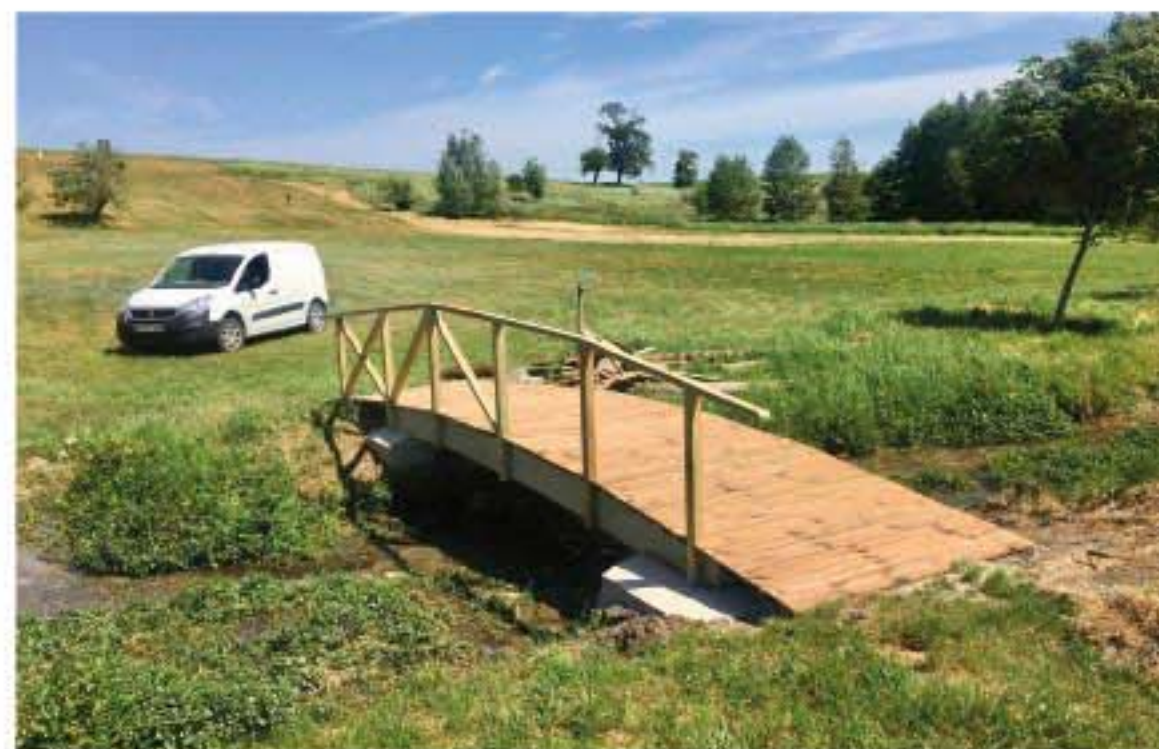
Passerelle rénovée au moulin du Berceau.
