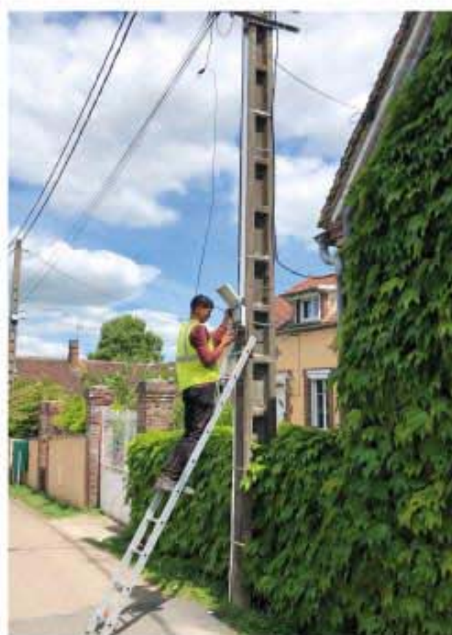
Travaux pour l'installation de la fibre dans Grande Rue.
